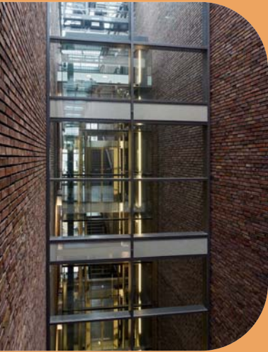
F (EI) 90-Innenfassade mit Pilkington Pyrostop ® zum Schutz eines Treppenraumes im Museum Schnüttgen, Köln.
